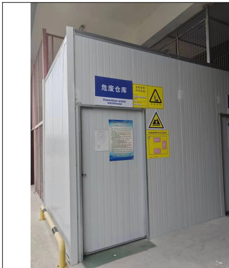
危废仓库外部
