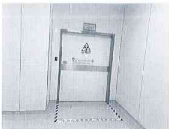
患者出入防护门工作状态指示灯和电离辐射警示标志、警示线
